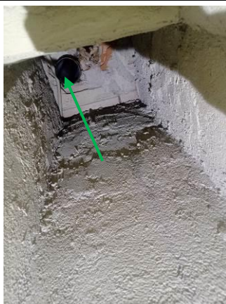
Retrait de conduit fibre-ciment (MPCA)
